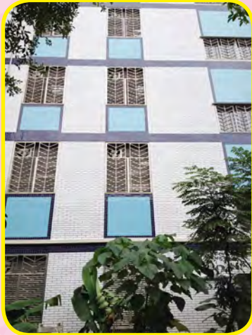
信義樓梯間外牆滲露整修煥然一新
